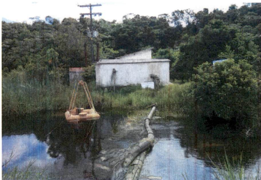
Captação no Córrego do Pau Alto (desativada). Fonte: Arquivo Prefisan.
