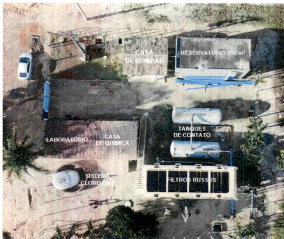
Estação de Tratamento de Água de Itabatã. Fonte: Arquivo Prefisan.
