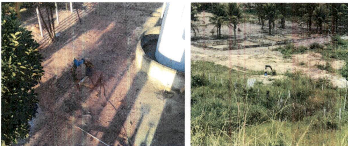
Poços de captação. Fonte: Arquivo Prefisan.
