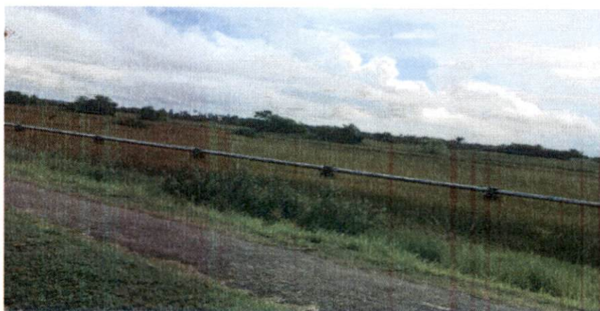
Adutota de Água Tratada – RAP 100 m 3 até RAP 450 m 3
