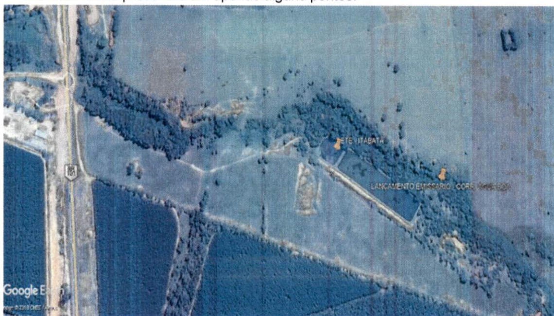
ETE e lançamento de esgoto. Fonte: Google Earth.
